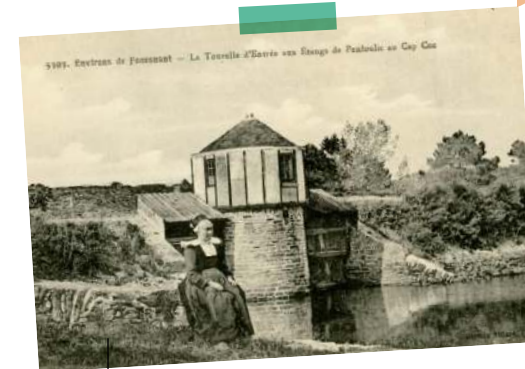
La "maison ronde" située sur la grande digue de 1871 n'a jamais été un moulin à marée, elle servait d'abri au garde d'astreinte pour ouvrir et fermer les vannes.
