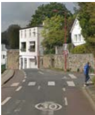
La traversée est ici matérialisée en extrémité de CVCB, donnant la priorité aux cyclistes et piétons sur les voitures pour rejoindre la voie verte (D4, Bram, Occitanie)
