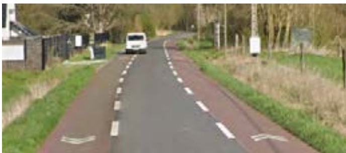
CVCB avec marquage coloré, bandes larges et chevrons. (D119, Templeuve en Pévèle, Hauts-de-France)
