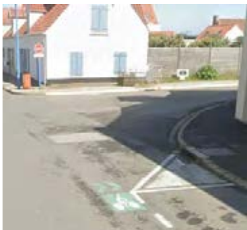
Exemple de marquage au sol sur la vélomaritime (R Edouard Quenu, 64 Audresselles, Hauts-de-France)
