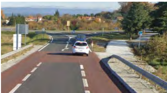
La traversée est ici matérialisée en extrémité de CVCB, donnant la priorité aux cyclistes et piétons sur les voitures pour rejoindre la voie verte (D4, Bram, Occitanie)
