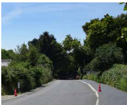
Juin : Travaux d'aménagement de voirie route du Cranic à La Forêt-Fouesnant.
