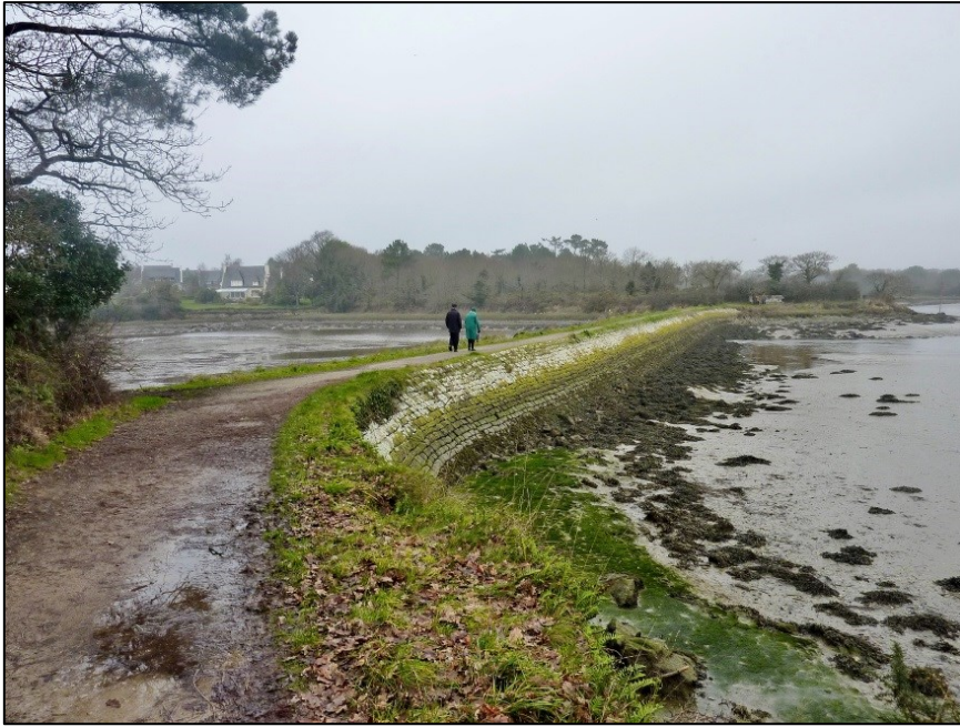
Figure 24 –Digue non classée localisée au niveau de l'estuaire de Pont-l'Abbé (Anse du Guerdy)
