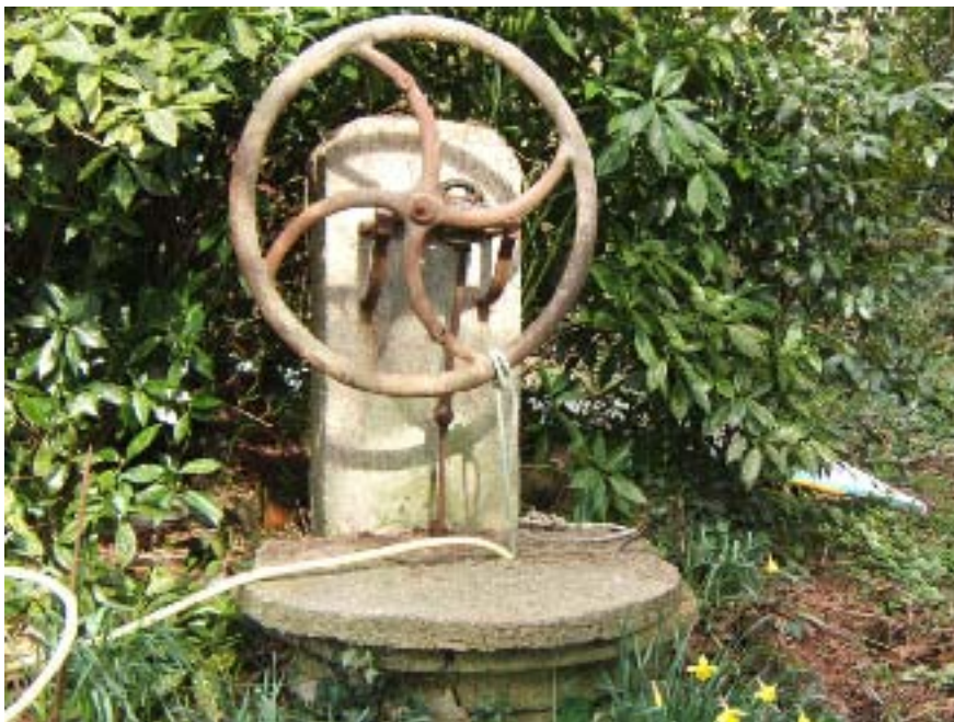
Le puits est équipé d'une pompe que l'on actionne par une roue
