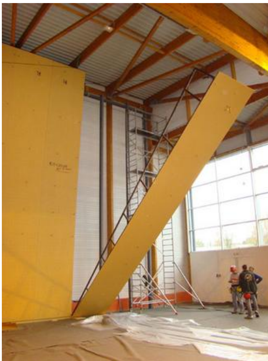
28 octobre : pose du premier côté du mur d'escalade
