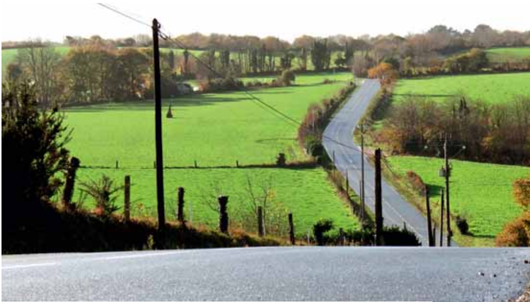
Un tapis d'enrobé a été réalisé sur la route de Saint-Evarzec vers Troyalac'h.
